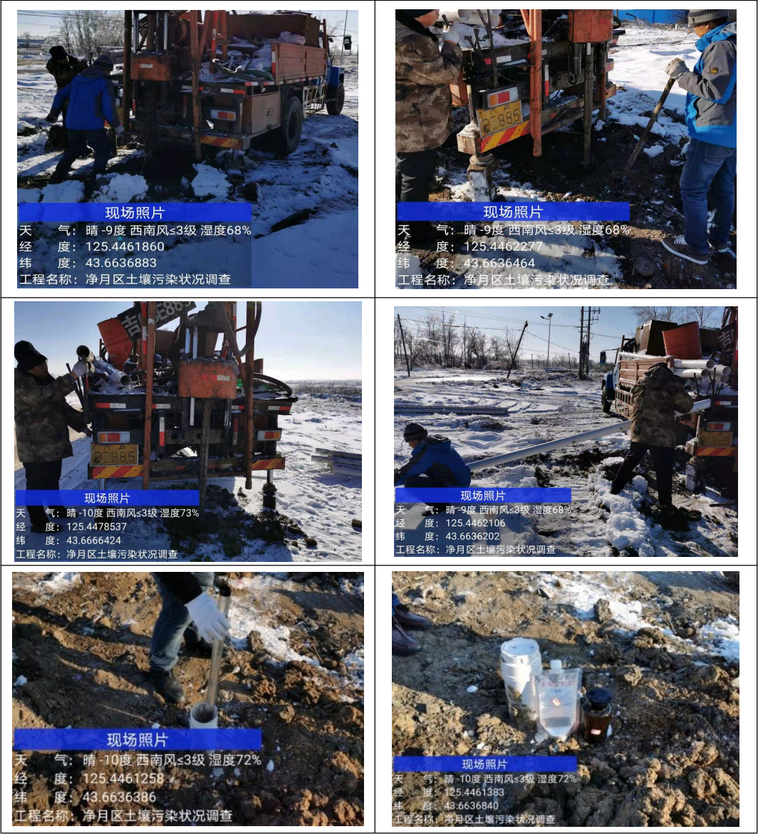
图 7-4 地下水建井及采样过程
